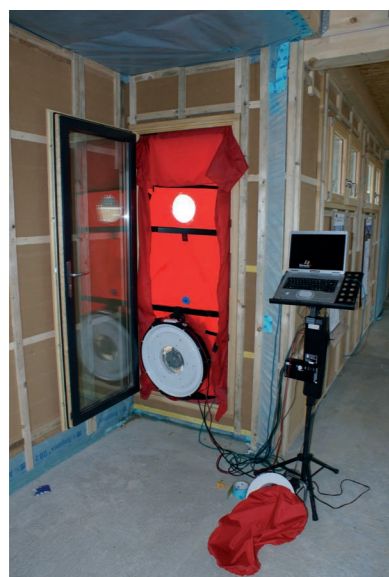
Test d'étanchéité à l'air
