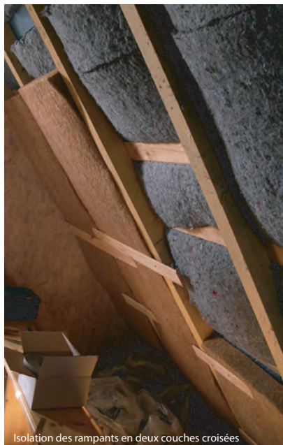
Isolation des rampants en deux couches croisées
