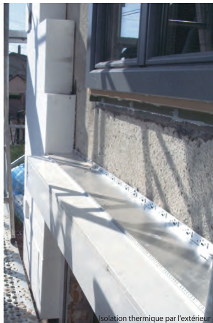
Isolation thermique par l'extérieur
